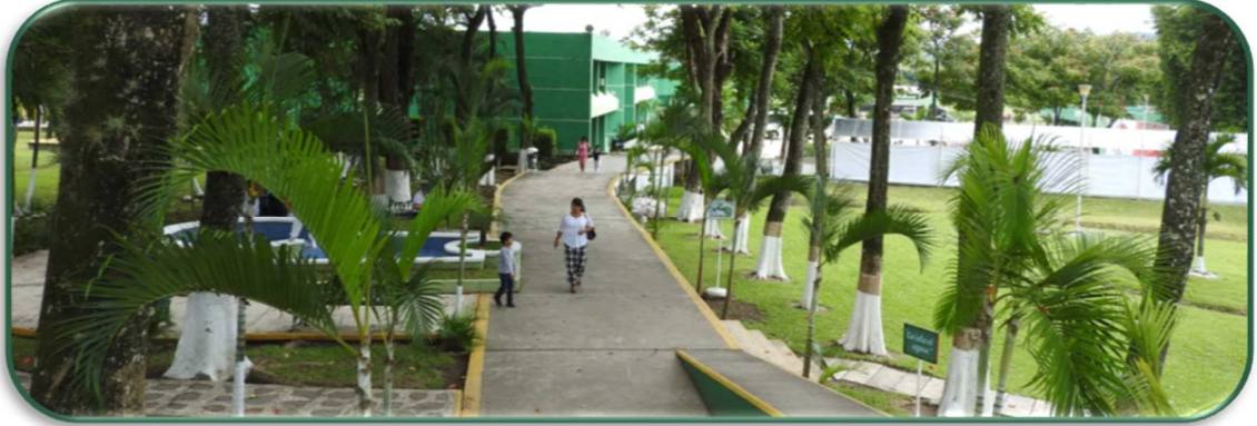
Acceso al Edificio Principal
